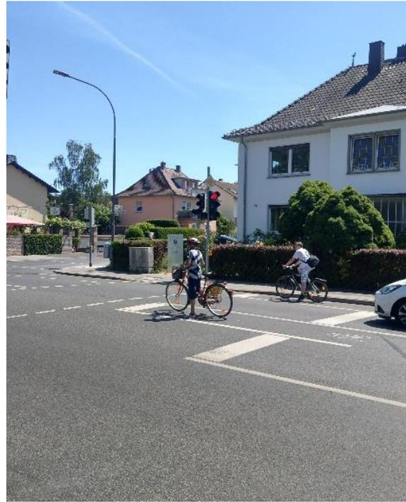
Teilweise muss jedoch kritisiert werden, dass einige gute Ideen nur schwierig umzusetzen sind, was an einigen Knotenpunkten deutlich wird (siehe Abbildung 29). Grundsätzlich ist die Aufstellfläche am Knoten positiv zu sehen, allerdings ist die Aufstellfläche für linksabbiegende Fahrradfahrende nur zu erreichen, wenn die LSA rot ist. Ansonsten wird der linksabbiegende Radfahrende beim fließenden Verkehr aufgrund des fehlenden Radwegs konfliktträchtig im mehrspurigen Mischverkehr geführt.
